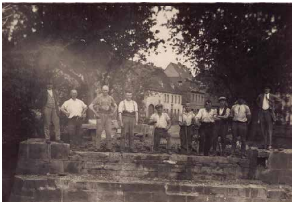
Bauarbeiter an der alten Bliesbrücke 1938, ein Blatt im neuen Dorfkレンダー. Foto: Verein für Orts- und Familiengeschichte Oberlinxweiler
